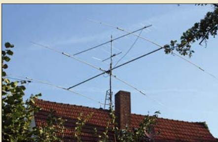
Jede Antenne zeigt irgendwann Ausfallerscheinungen, wenn sie über viele Jahre der Witterung ausgesetzt ist. Insbesondere Sperrkreise gehören zu den empfindlichen Elementen. Wie man sie reparieren kann, wird hier am Beispiel eines Fritzel-Beams beschrieben. Foto: DK7ZB
